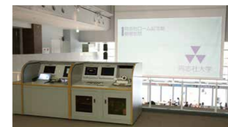
大型プロジェクタ投影システム 10600ANSIルーメンの照度を持つ大型プロジェクタを設置し、昇降式の巨大スクリーン上に各種映像を投影できます。
